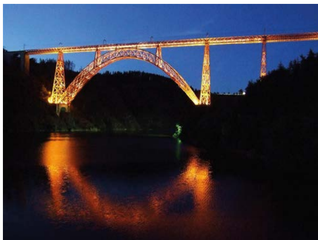
Viaduc de Garabit © Crédit Les Pays de Saint-Flour
